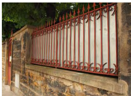
clôture en fer forgé à conserver
