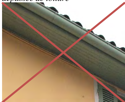
les dépassées de toitures lambrissées sont proscrites...
