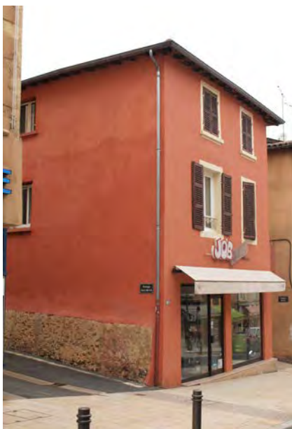
enduit traditionnel à la chaux rue Nationale
