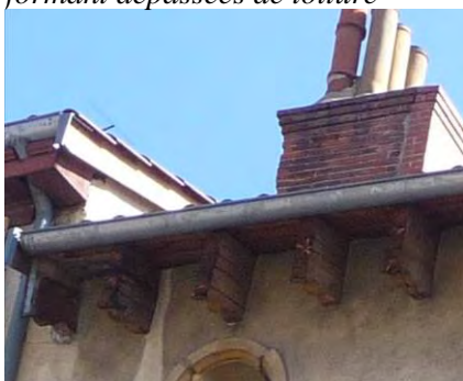
dépassée de toiture à chevrons débordant sculptés
