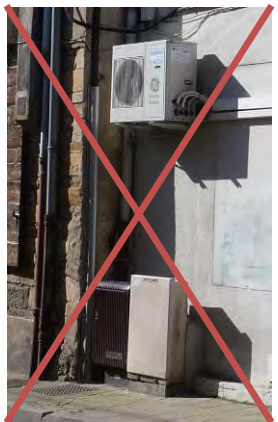
Appareils divers en applique sur la façade
