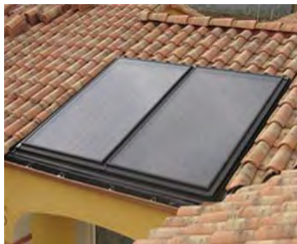
exemple de panneaux solaires thermiques
