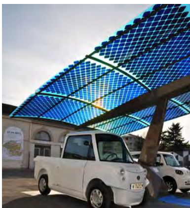
« ombrières » photovoltaïques sur un parking
